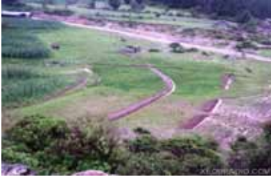
Zanjas de coronación e infiltración
